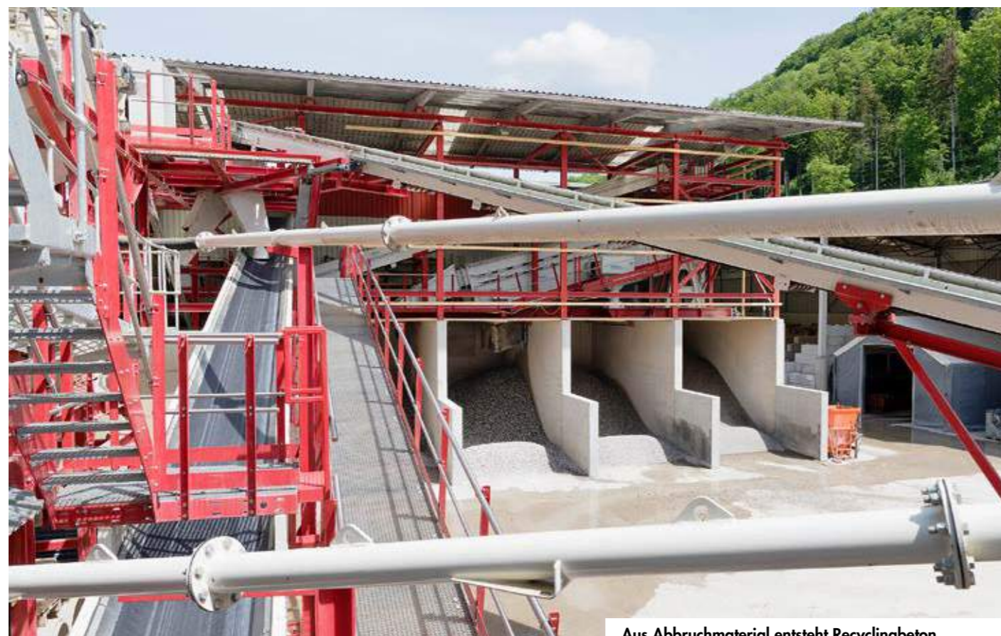
Aus Abbruchmaterial entsteht Recyclingbeton.
